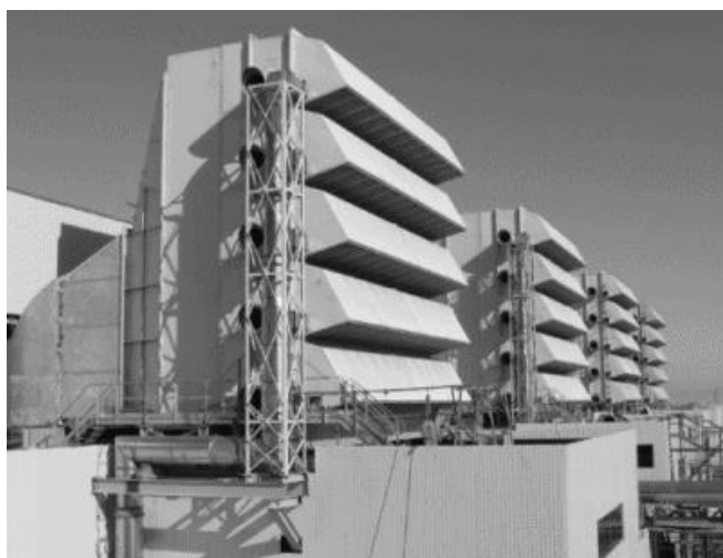
شکل ۱. سامانه ورودی هوای توربین گاز V94.2
