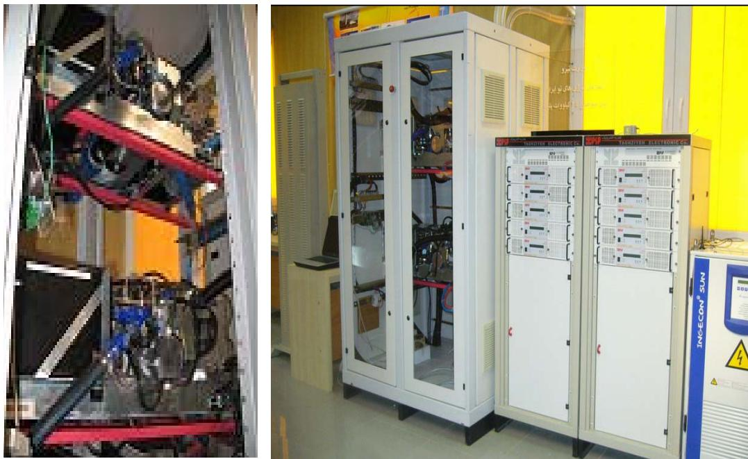
شکل (۲۰) : پیل سوختی ۲۵ کیلووات پلیمری متصل به شبکه سایت طالقان
