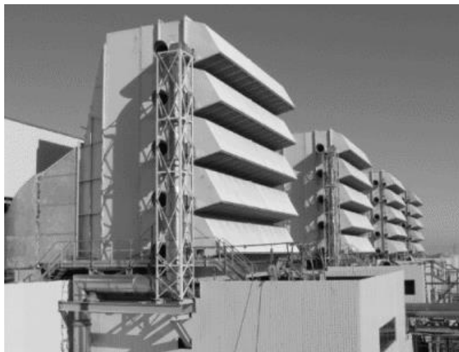
شکل ۱. سامانه ورودی هوای توربین گاز V94.2
