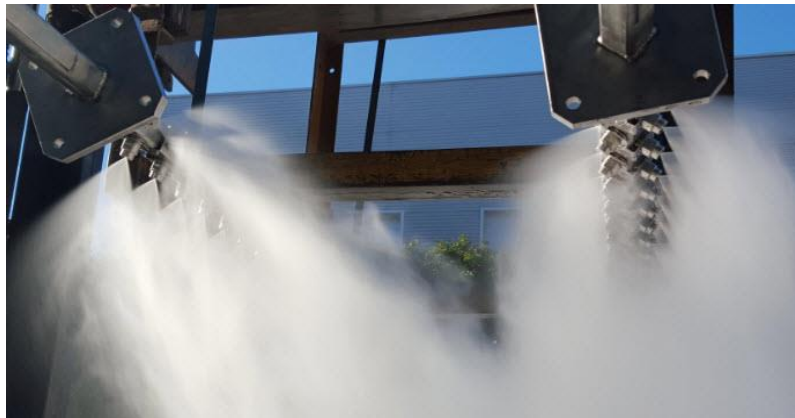
شکل ۳. تست نحوه پاشش آب توسط نازل‌ها قبل از نصب
