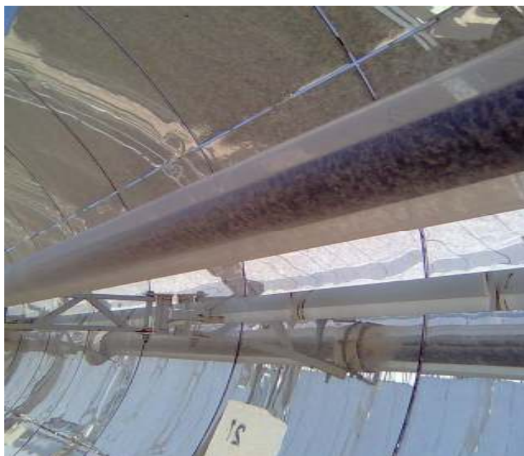
شکل ۶: لوله شیشه‌ای و آینه‌های کثیف کلکتور نیروگاه خورشیدی شیراز
