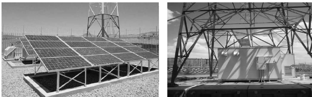
شکل ۲) بکارگیری دیزل ژنراتور برای تأمین برق BTS شکل ۳) بکارگیری سیستم فتوولتائیک برای تأمین برق BTS
