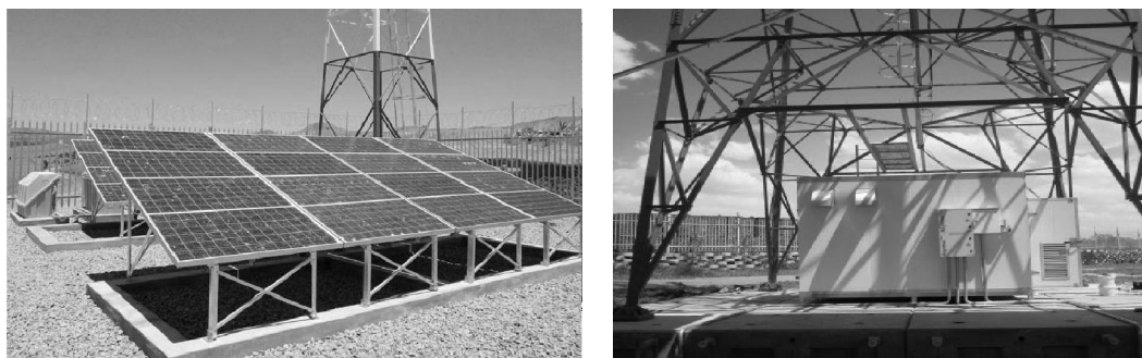
شکل ۲) بکارگیری دیزل ژنراتور برای تأمین برق BTS شکل ۳) بکارگیری سیستم فتوولتائیک برای تأمین برق BTS
