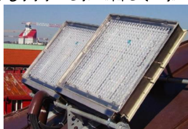
شکل ۸- جمع‌کننده نور خورشید برای سیستم فیبر نوری [۱]
