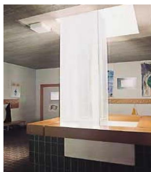
شکل ۲۰ - استفاده از هادی منشوری توخالی برای پخش نور [۶]
