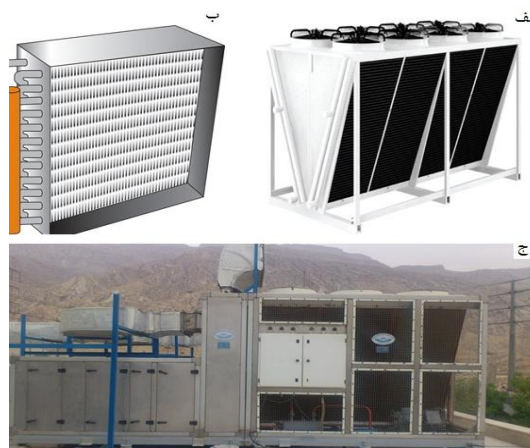
شکل (۲) تصویر سیستم HVAC مورد مطالعه، الف) تصویر کندانسور V-Type، ب) تصویر اواپراتور، ج) نمای کلی پکیج HVAC
