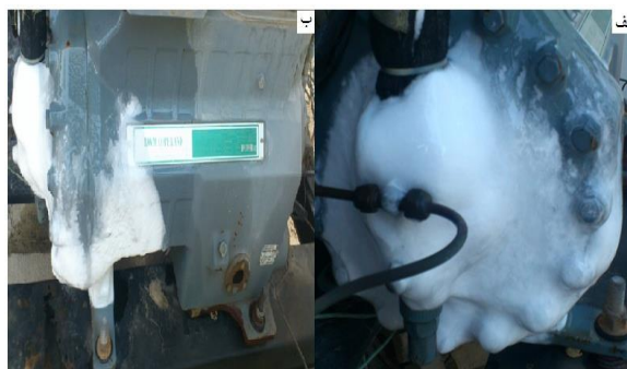
شکل ۳) تصویر یخ زدگی کمپرسور از دو نمای مختلف، الف) نمای مقابل، ب) نمای جانبی
