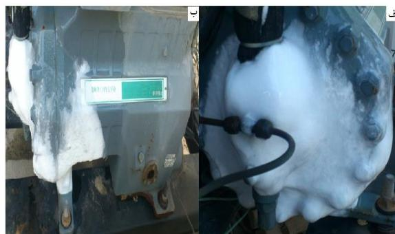
شکل (۳) تصویر یخ زدگی کمپرسور از دو نمای مختلف، (الف) نمای مقابل، (ب) نمای جانبی
